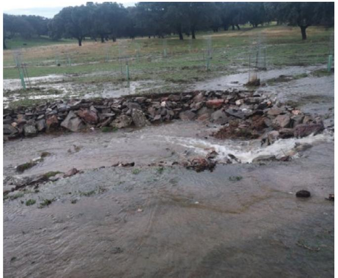
As estruturas de controlo torrencial, para desaceleração da energia de escorrência da água, devem ser adaptadas à dimensão do problema. Neste caso, as soluções preconizadas referem-se à intervenção em pequenas linhas de água ou barrancos, existentes à escala de uma exploração agro-florestal de Montado, e não a ribeiras e rios, cuja intervenção carece de soluções mais complexas.
